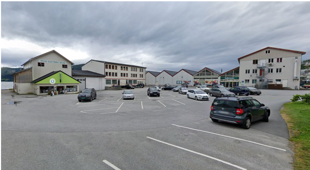
Figur 2 Foto som viser dagens arealbruk sett frå aust. Kjelde: Google Maps
